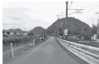
県道344号大草三原線長谷地区
