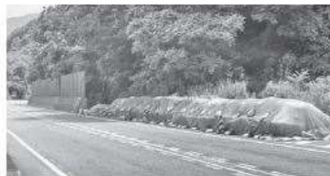
土石流危険のある処分場入口の防護壁
