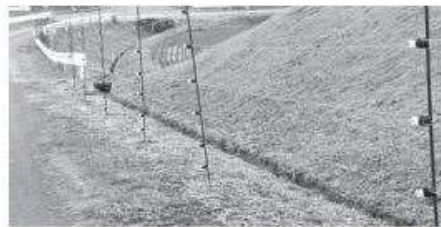
市道の路肩に設置された電気柵（侵入防護柵）
