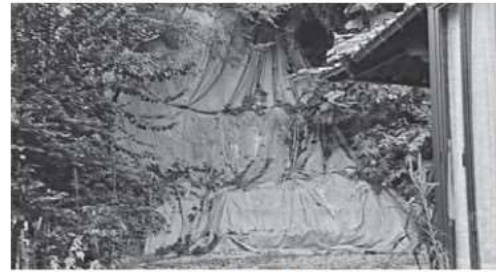
裏山が崩れた民家
